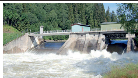
Inntaksdammen i Ramfoss - som ligger like ved Kløtgefoss
