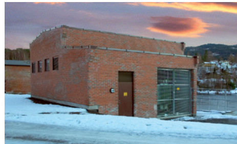
Kongsfoss kraftstasjon ved Åmot
