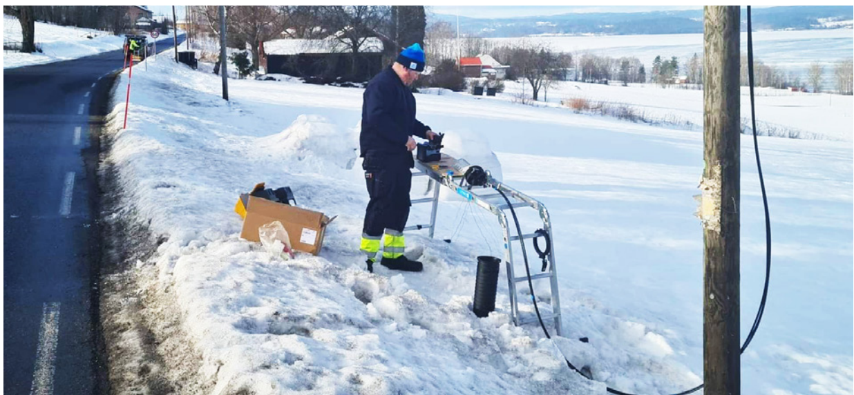
Skjøting av fiber på Øst-modum, foto: Stian Engen
