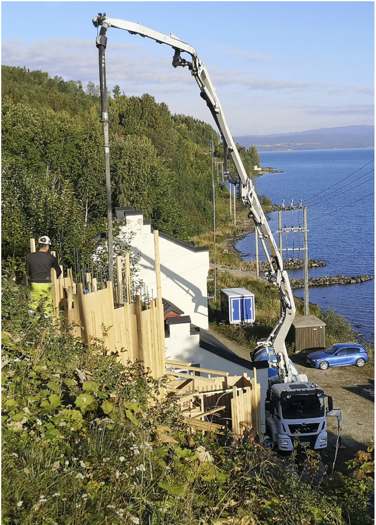
Forsterking av rørfundamenter på Dyrbak kraftverk, foto: Jørgen Lislott
