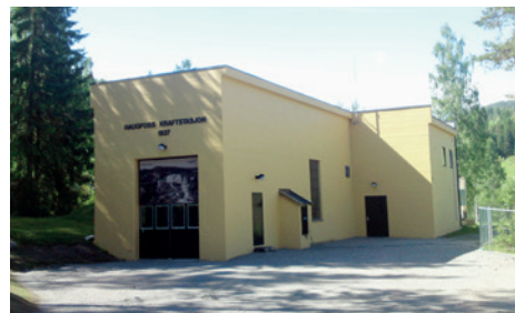
Haugfoss kraftstasjon ved Blaafarveværket
