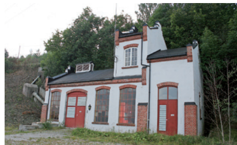
Dyrbak kraftstasjon på Østmodum
