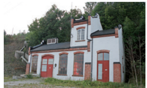
Dyrbak kraftstasjon på Østmodum
