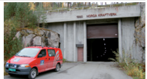
Inngangspartiet til Horga kraftstasjon ved Soneren i Sigdal
