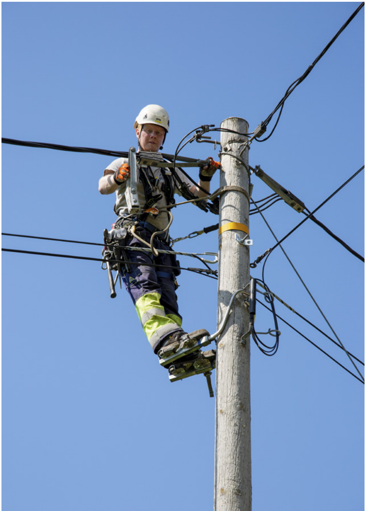
Vetle Båsen fjerner gammelt luftstrek i Sigdal, foto Trond Lindseth
