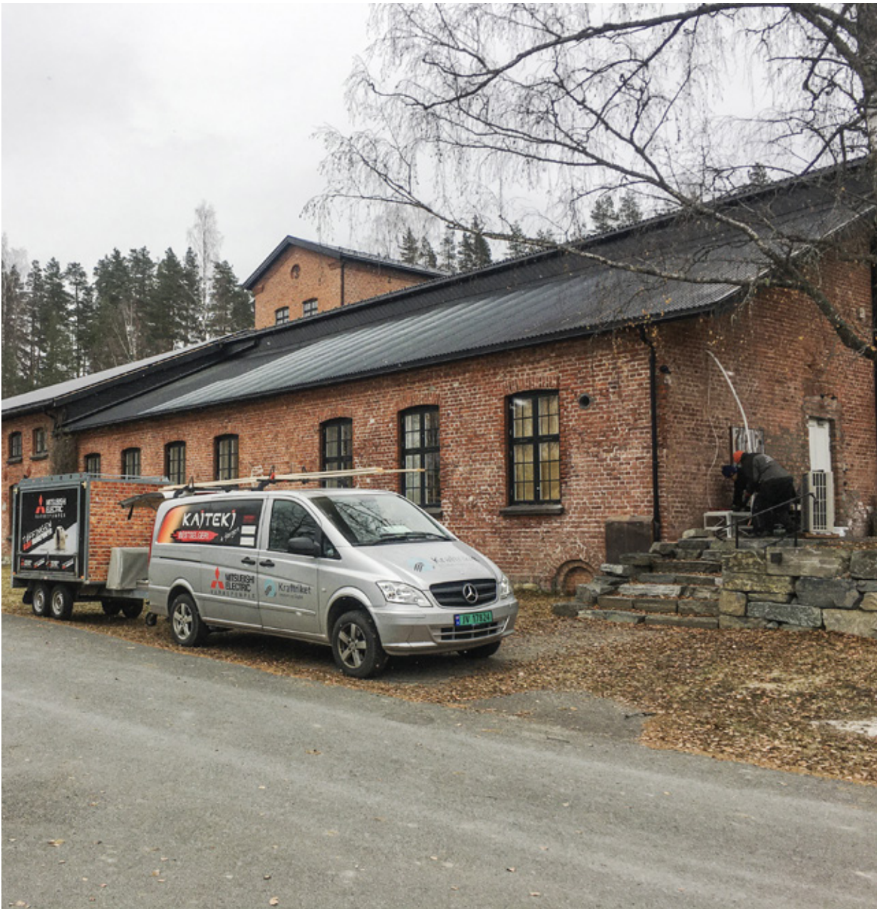
Kraftriket monterer to store varmepumper hos Blaaifarveværket, foto: Trond Lindseth
