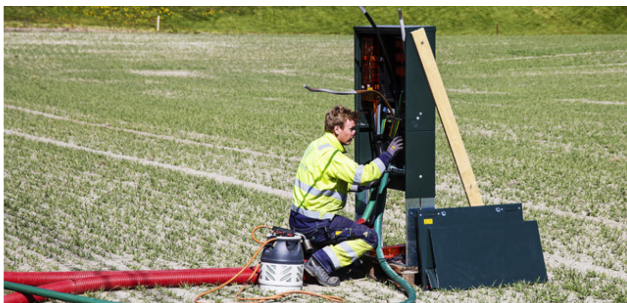
Truls Bratvold Fossen klargjør provisorisk kabelskap ved Badeveien, foto: Trond Lindseth
