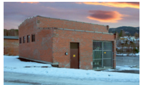
Kongsfoss kraftstasjon ved Åmot
