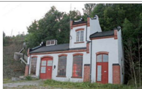
Dyrbak kraftstasjon på Østmodum
