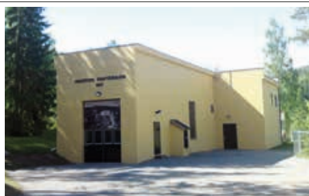
Haugfoss kraftstasjon ved Blaafarveværket
