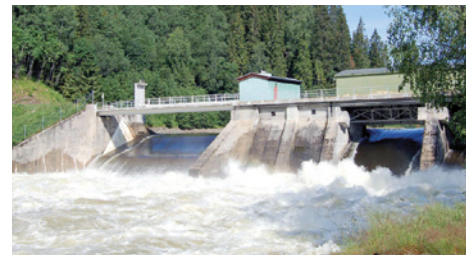
Inntaksdammen i Ramfoss - som ligger like ved Kløftefoss
