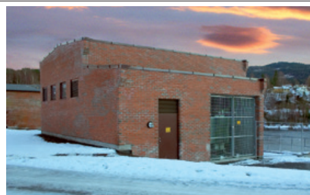
Kongsfoss kraftstasjon ved Åmot
