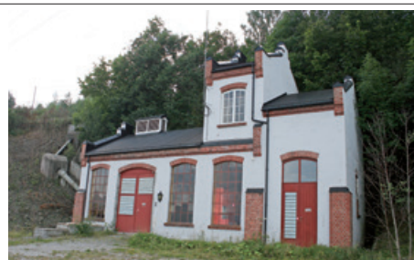
Dyrbak kraftstasjon på Østmodum
