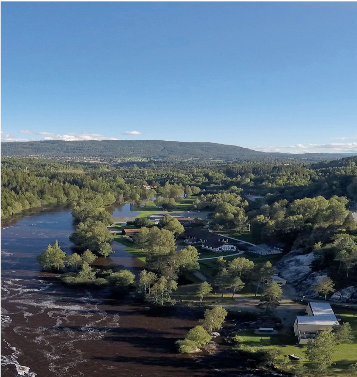
Haugfoss kraftstasjon og Blåfarververket i fugleperspektiv. Dronefoto: Trond Lindseth
