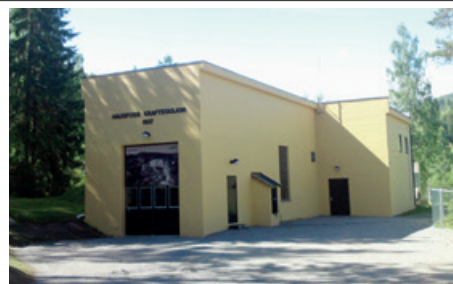
Haugfoss kraftstasjon ved Blaafarveværket
