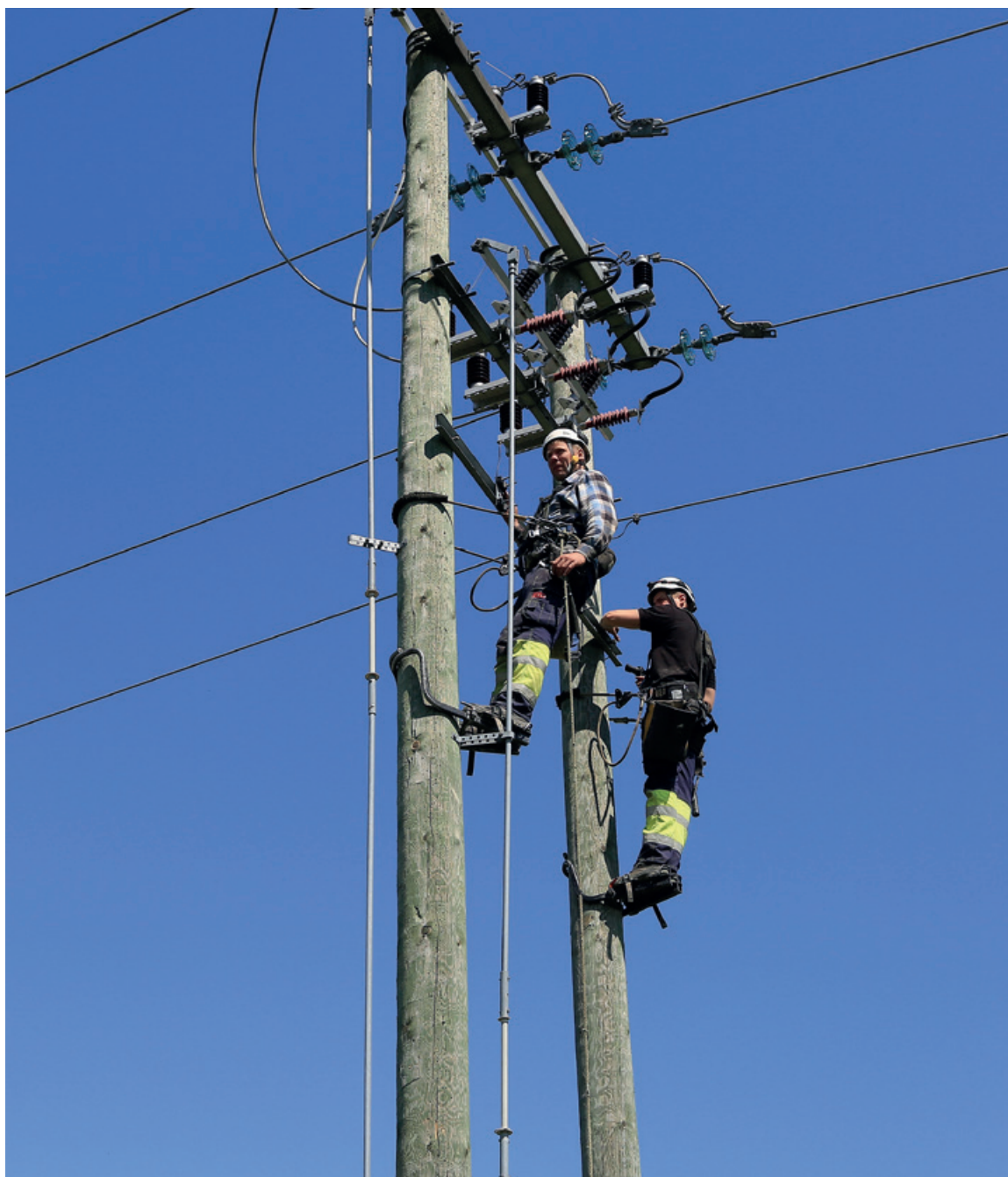
Kabelbytte på Skinstad. Foto: Trond Lindseth
