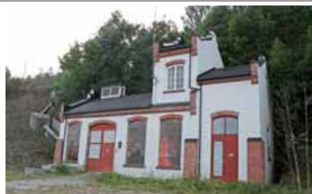
Dyrbak kraftstasjon på Østmodum
