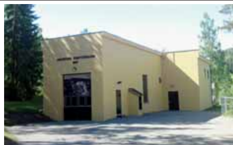
Haugfoss kraftstasjon ved Blaafarveværket
