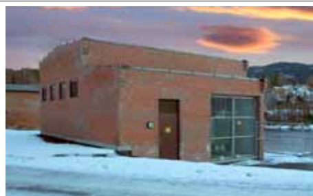
Kongsfoss kraftstasjon ved Åmot
