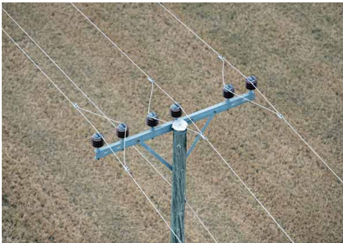
Lavtflygning med termofotografering for å avdekke «usynlige feil», foto Jacob Rustad, Nettpartner AS.
