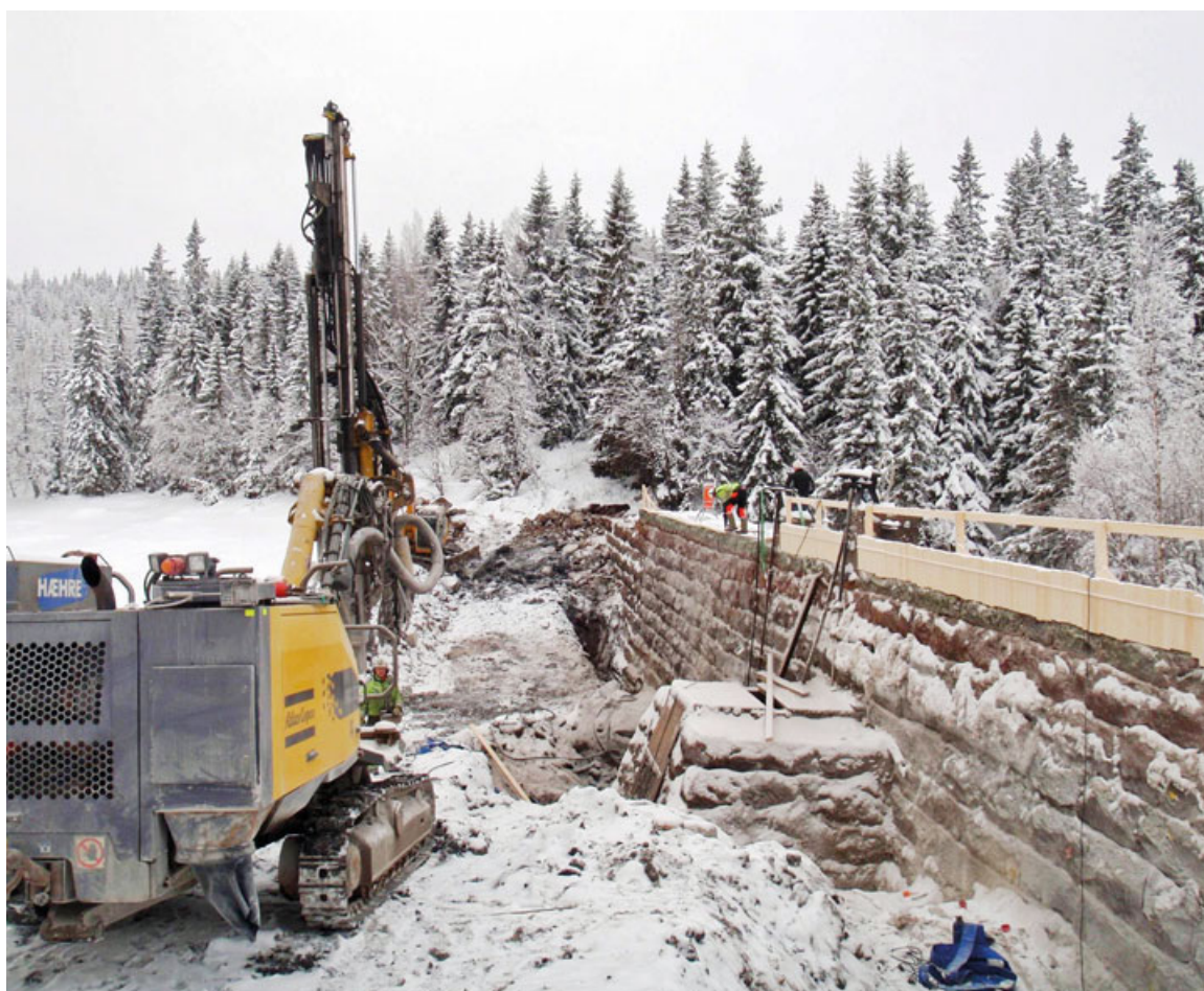
Oppstart av rehabiliteringsarbeider på Vesledammen vinteren 2013, foto: Nevreza Hurtic.
