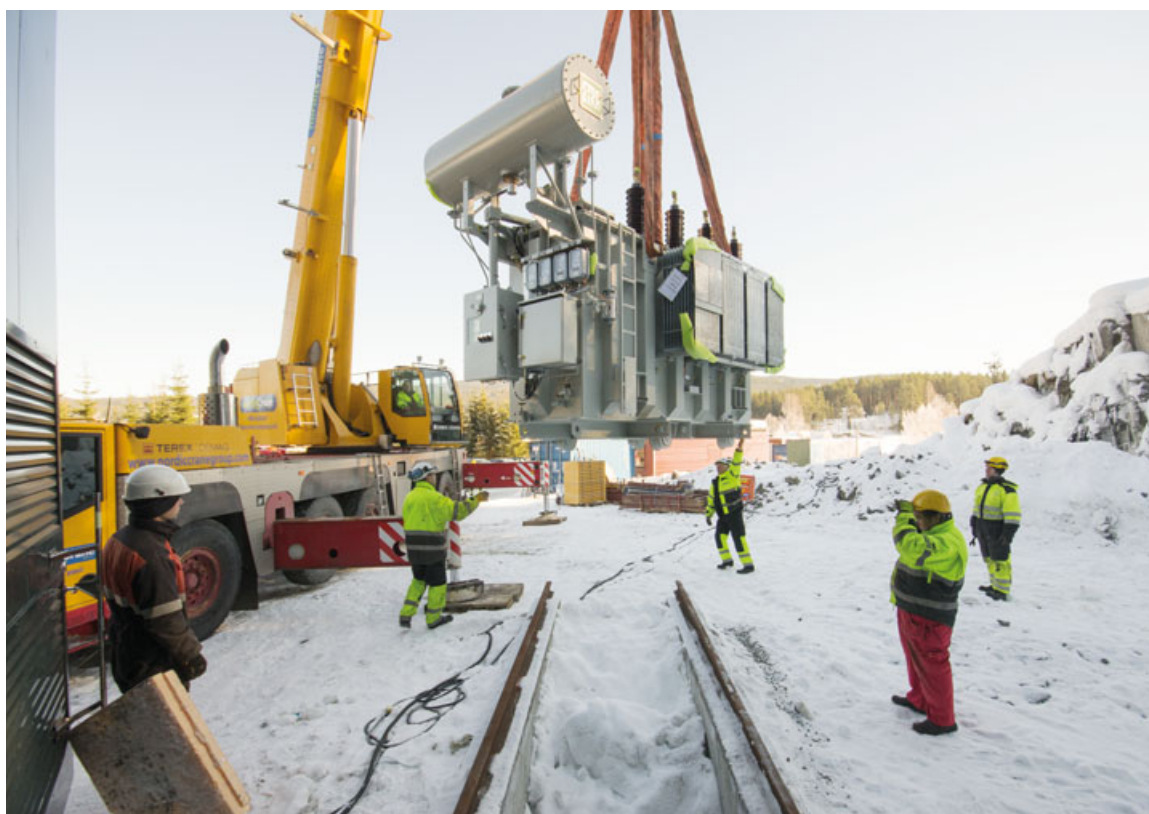
Trafoen på Sundbakken trafostasjon løftes på plass, foto Erik Thalerud.
