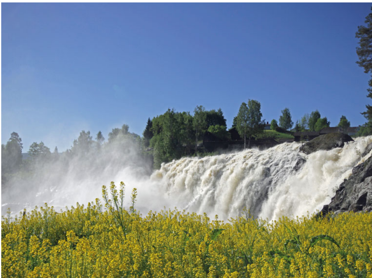
Ikke alt vannet kommer igjennom Haugfoss kraftstasjon i vårflommen, foto Trond Lindseth.
