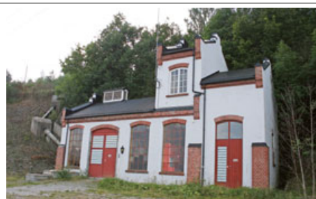
Dyrbak kraftstasjon på Østmodum
