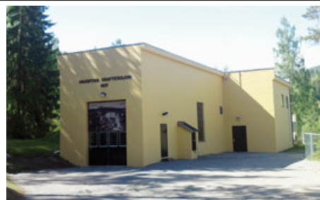
Haugfoss kraftstasjon ved Blaafarveværket
